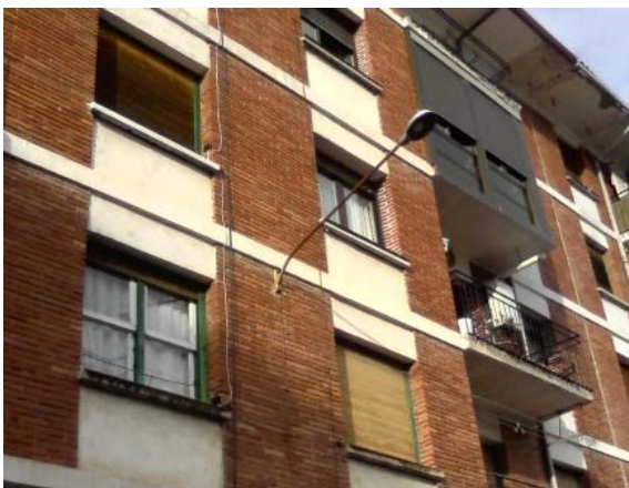
Calle antes de ser renovada
